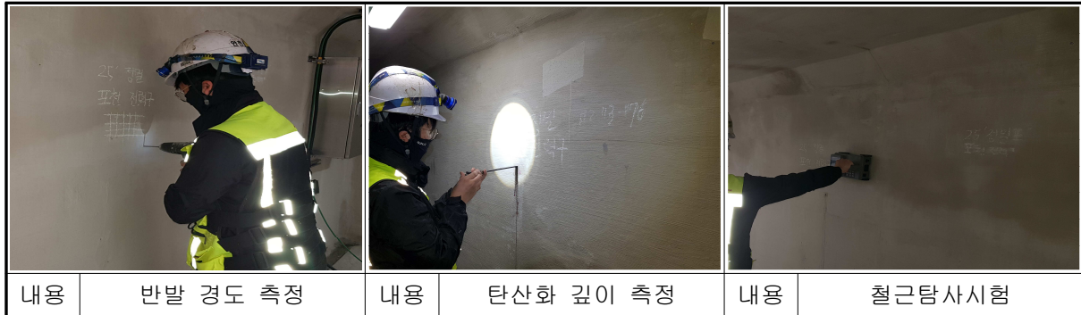
【사진 2.5】 포천인출 전력구 재료시험 전경
