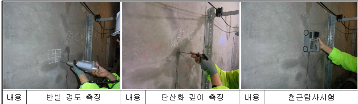
【사진 3.4】 문발SS인출 전력구 재료시험 전경
